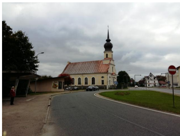
5.attēls . Valsts autoceļš A7 Rīga-Bauska-Lietuvas robeža (Grenctāle) – Rīgas iela.
